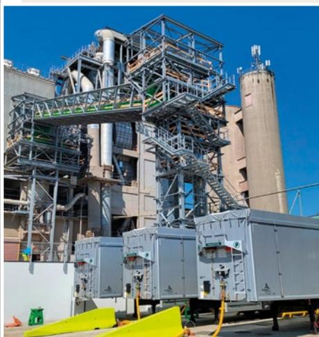
Ofenfertige Anlieferung: Im neuen Ladeterminal »EBS 5« gehen die Ersatzbrennstoff-Lieferungen direkt vom Anhänger zur Ofenanlage.
